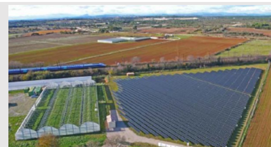
Centrale Solaire de LUNEL Département : Hérault (34) Puissance électrique : 500kWc Mise en service : Septembre 2008
