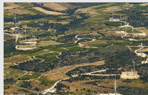
Parc éolien de FENOUILLEDES : Département : Pyrénées Orientales (66) Puissance électrique : 23,5MW 10 éoliennes Mise en service : novembre 2018
